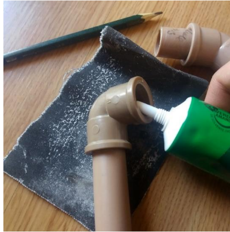
Figura 39. Aplicação de cola no cano lixado para fixação.
