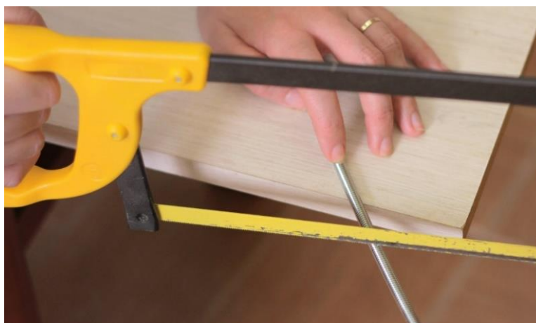
Figura 84. Corte da barra zincada roscada.
