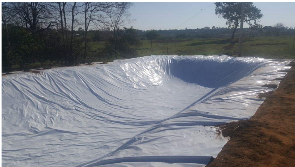
Figura 21- Construção do tanque de irrigação na Etec de Jales.
