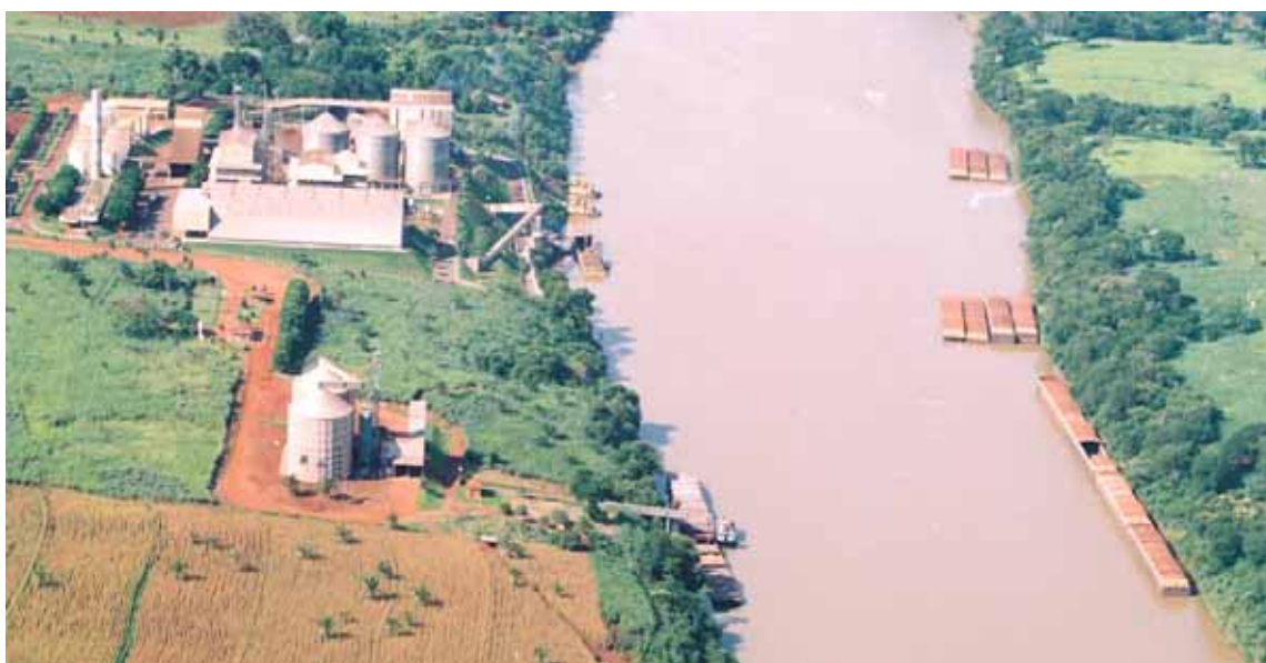
Figura 8. Terminal hidroviário de São Simão (GO). Fonte: (PREFEITURA MUNICIPAL DE SÃO SIMÃO, 2006).
