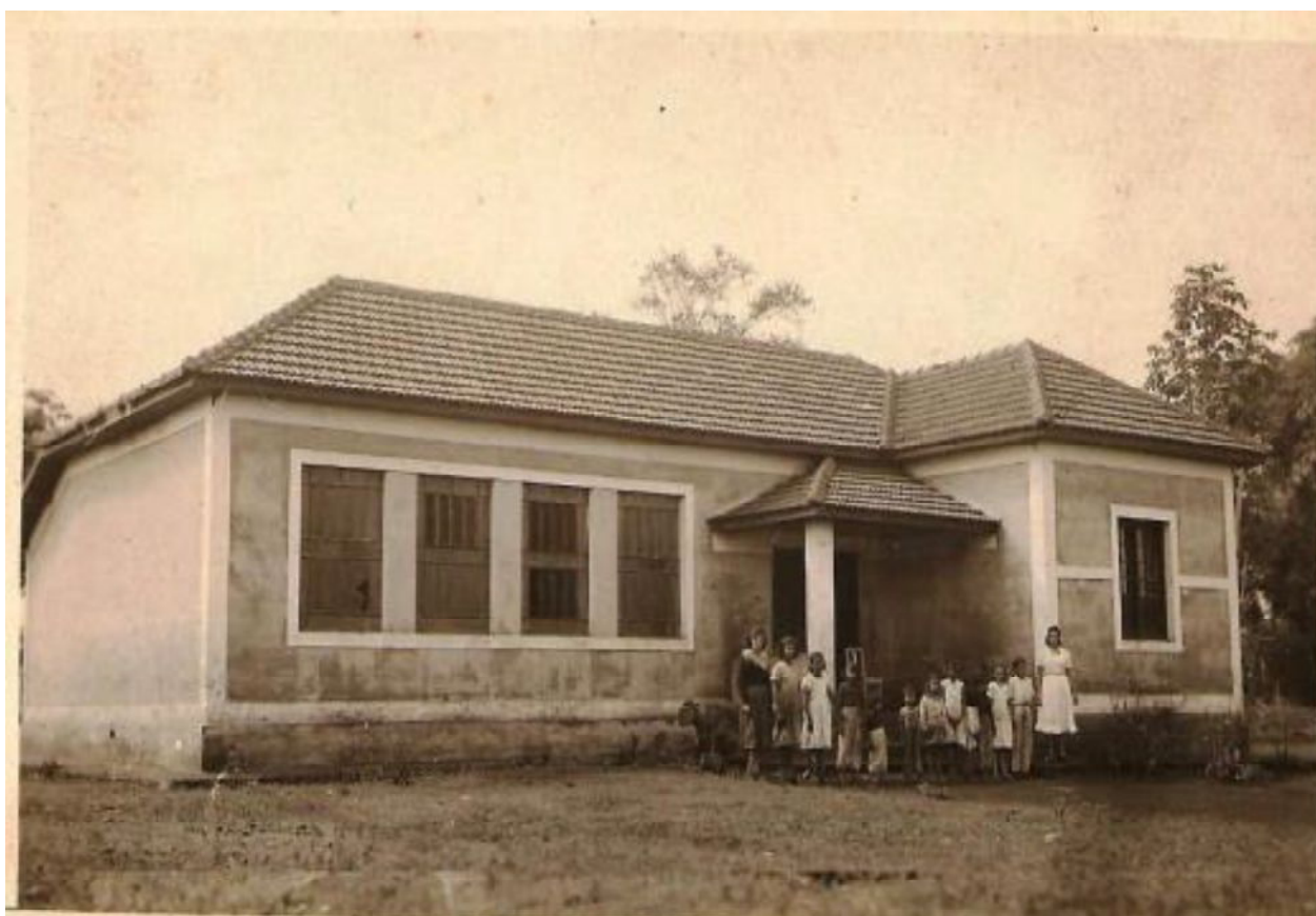
Ilustração 01- Fachada da escola Geraldino Neves Corrêa (década de 1950 MT) Fonte: IRALA (2013, p. 87).
