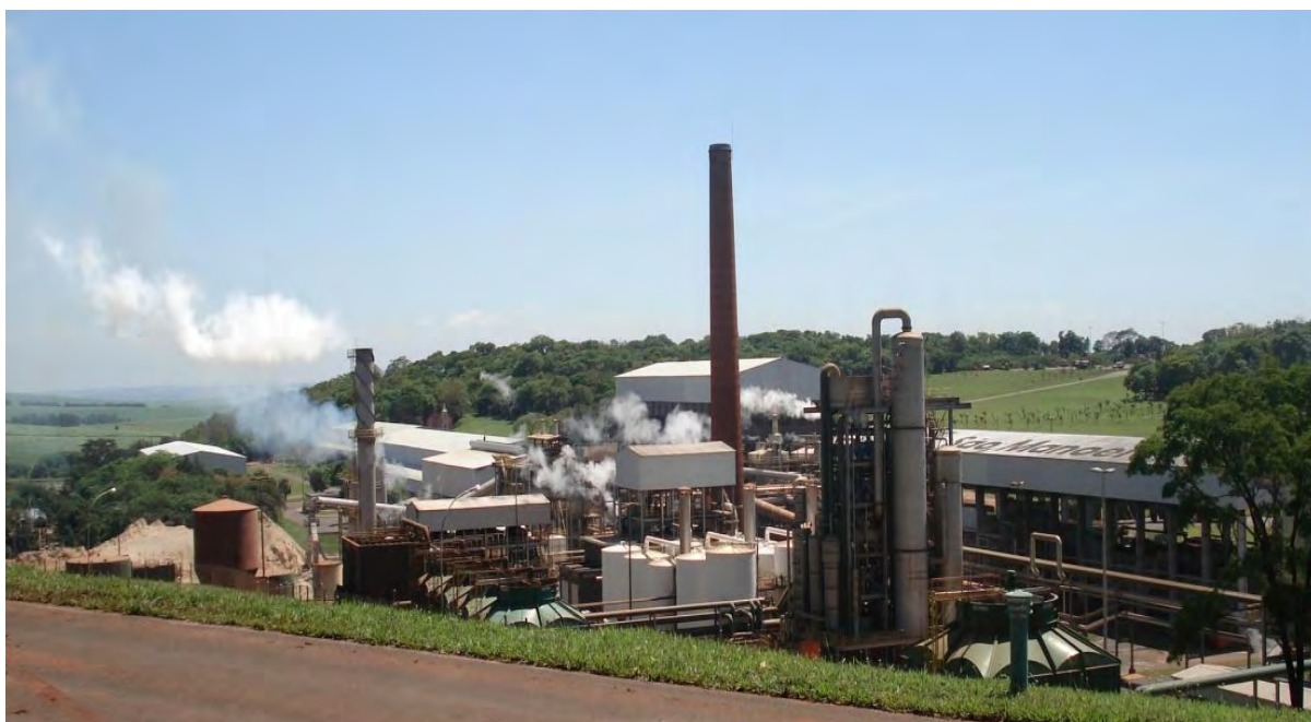
Figura 10 – Vista geral da Usina São Manoel.
