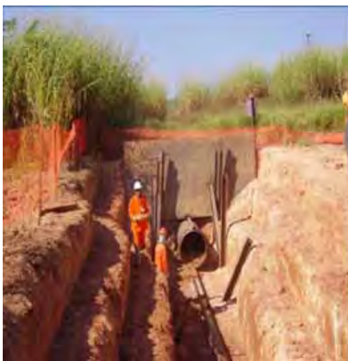
FIGURA 7: Cruzamento Estrada de Ferro FONTE: PETROBRAS
