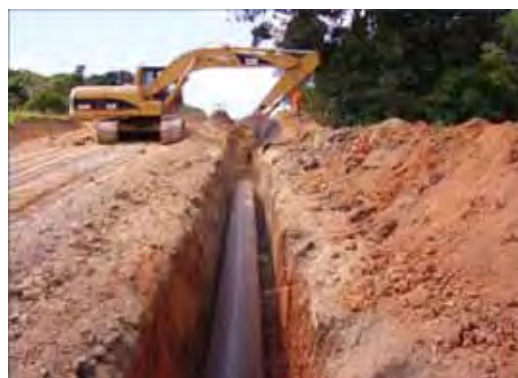
FIGURA 5: Cobrimento da vala
