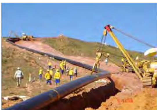
FIGURA 4: Abaixamento da tubulação
