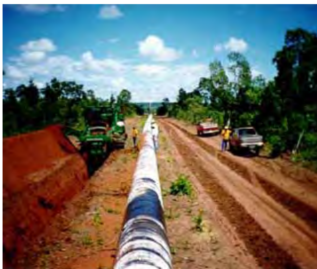
FIGURA 1: Abertura da Vala e Limpeza da faixa
