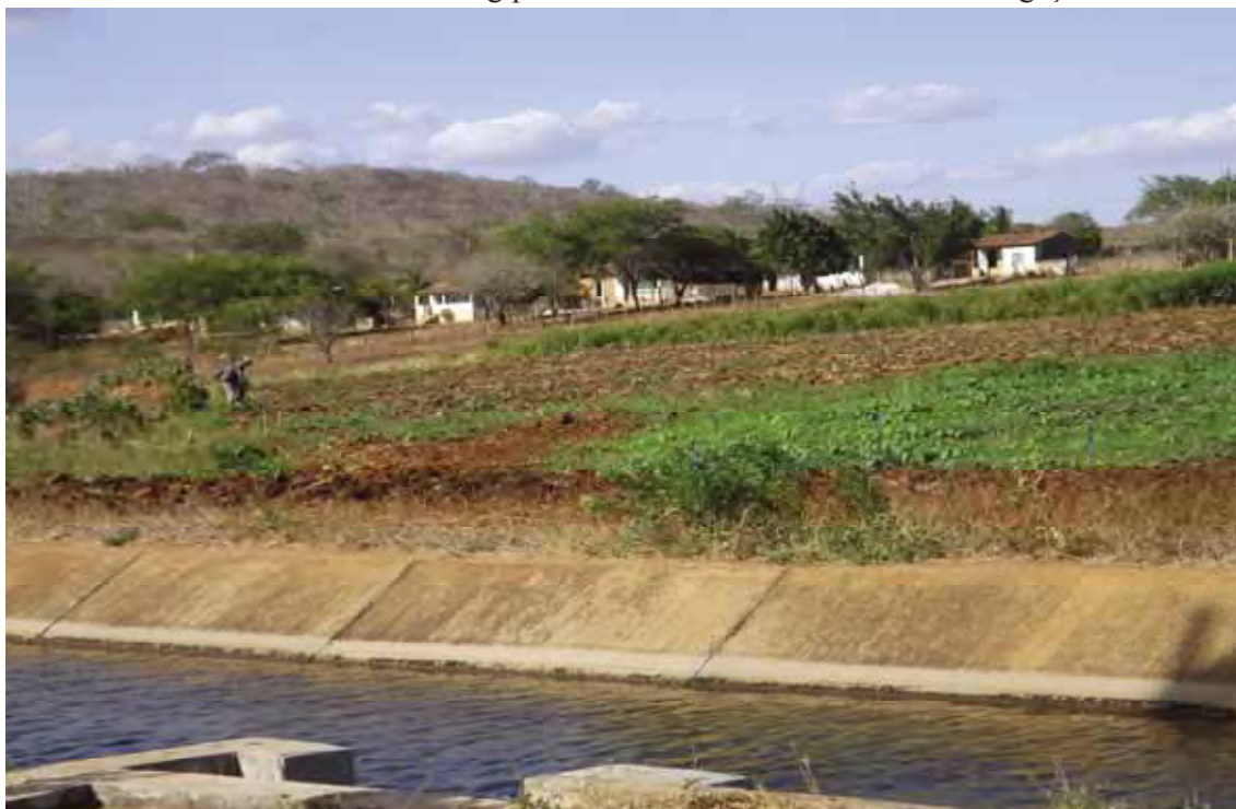
Foto 12 – Sergipe – PA Jacaré-Curituba – Canal de irrigação
