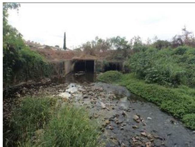
Figura 16 - Saída da canalização do Córrego da Servidão, depois de passar debaixo da Avenida Tancredo Neves. Acervo pessoal. Foto de maio/2016.
