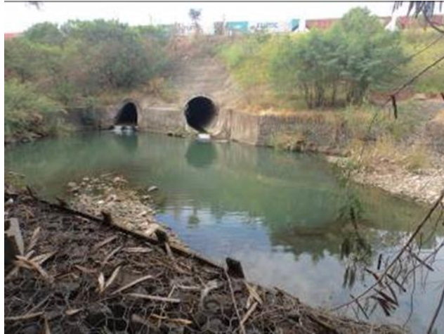
Figura 17 - Saída da canalização do Córrego da Servidão, depois de passar debaixo da ferrovia. Acervo pessoal. Foto de maio/2016.
