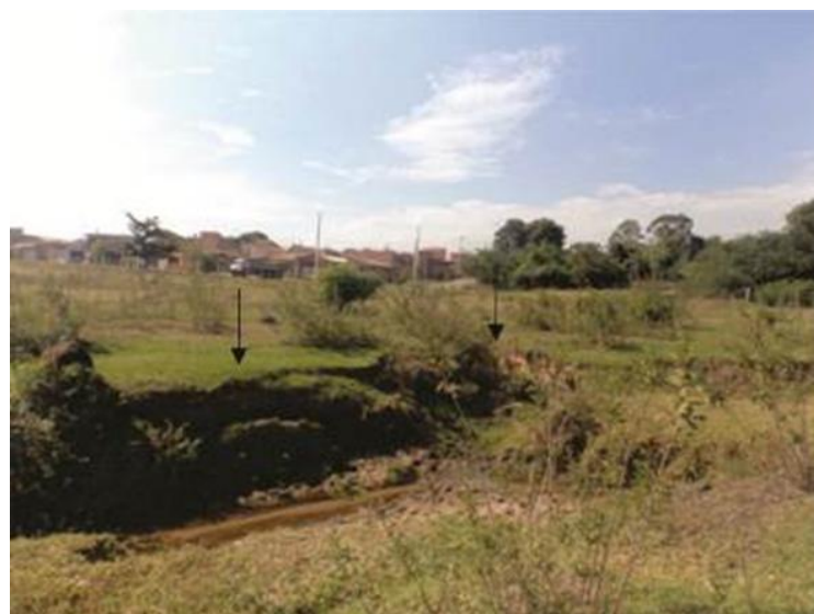
Figura 9 - Efeito erosivo das águas pluviais urbanas ao atingir um canal fluvial nas proximidades do Jardim Palmeiras. Considera-se que a intensa incisão fluvial, apontada pelas setas, indicam tal ação, excepcional para a dimensão do canal. Acervo pessoal. Foto de maio/2016.
