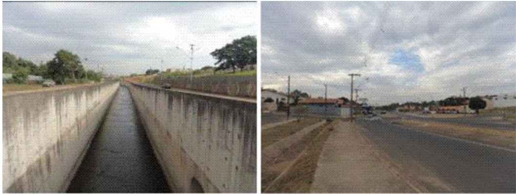
Figura 15 - Retilização e aterramento do córrego da Servidão. Acervo pessoal. Foto de maio/2016.
