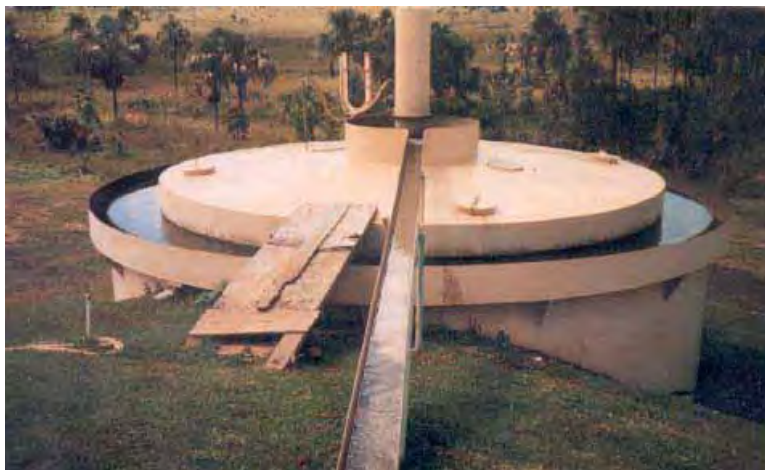
Figura 13 – Tanque anaeróbio ou sistema Imhoff (Fonte: http://www.etg.ufmg.br/tim2/tratamento2.ppt – 17/03/2007)
