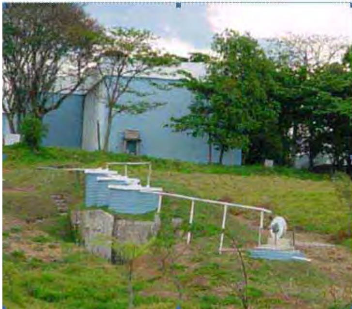
Figura 3 – Mini-estação de tratamento de esgoto implantada na UNESP, campus de Guaratinguetá, com a roda d'água em funcionamento
