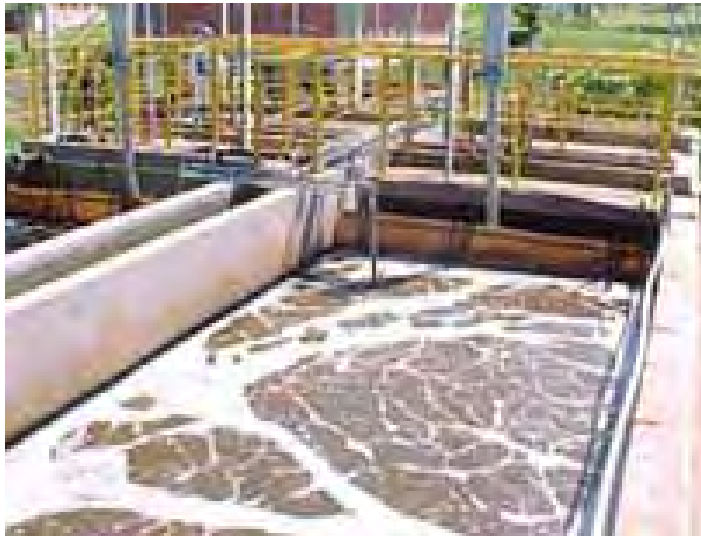
Figura 11 – Tanque de aeração com lodo ativado (Fonte: http://www.milenia.com.br/imagens/desenvolvimento/residuos/foto5.jpg – 17/03/2007)
