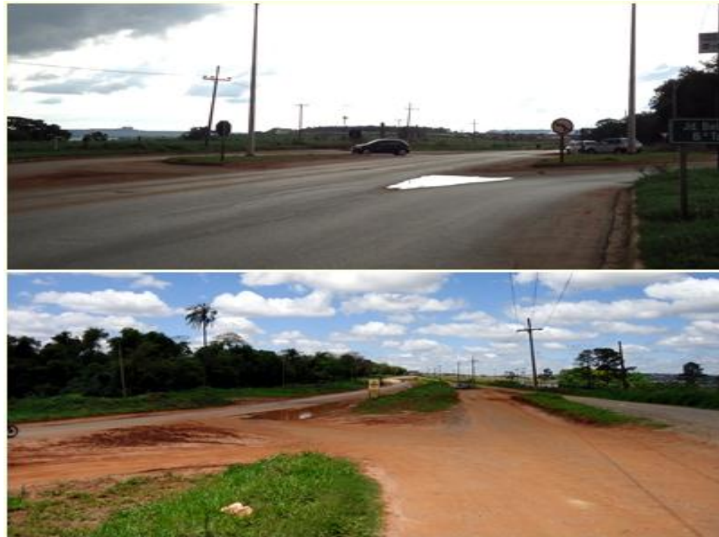
Figura 6 - Acesso ao bairro, via não pavimentada, ausência de calçadas, sinalização e iluminação.
