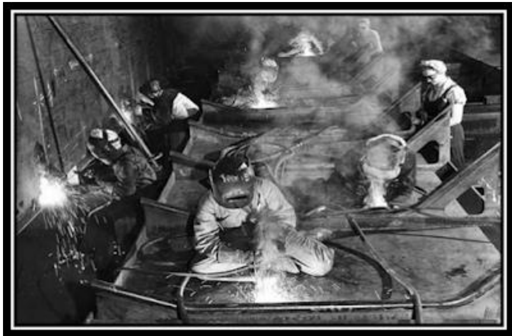
Figura 7 - Mulheres trabalhando na construção de um porta-aviões.
