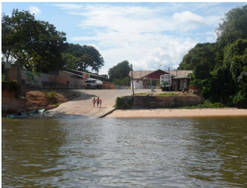
Figura 55 - Terminal Hidroviário construído no bairro da Aldeia em 2004 Fonte: José Carlos Cordovil (2015).
