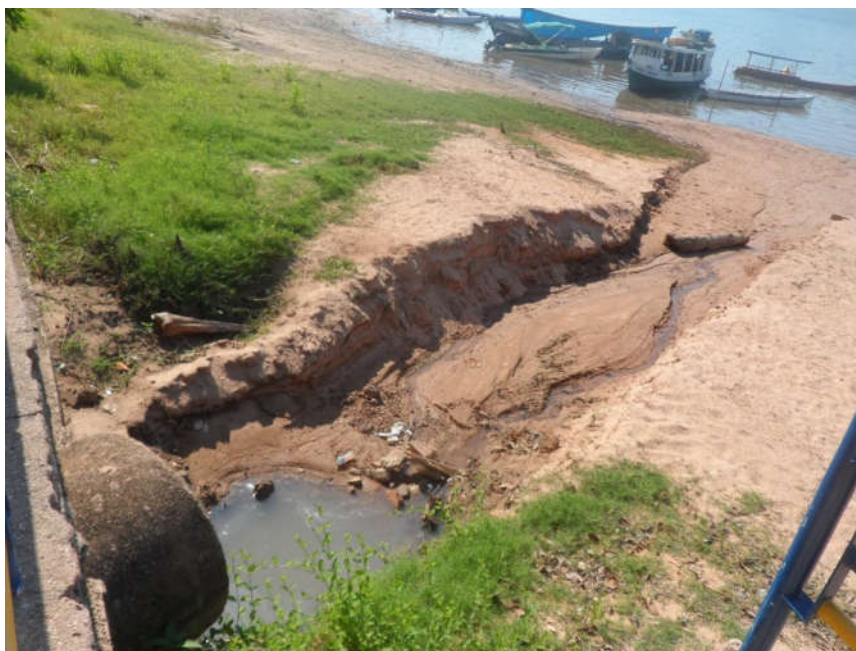
Figura 73 - Esgoto sendo despejado no rio próximo à praia em Alter do Chão. Fonte: José Carlos Cordovil (2016).
