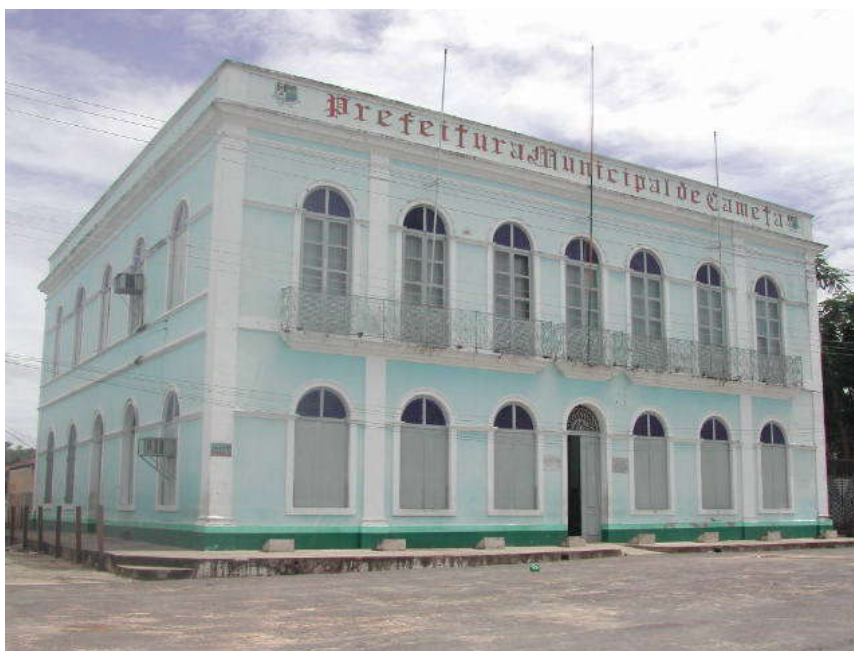
Figura 26 - Antiga Casa de Câmara e Cadeia construída no século XIX Fonte: José Carlos Cordovil (2015).
