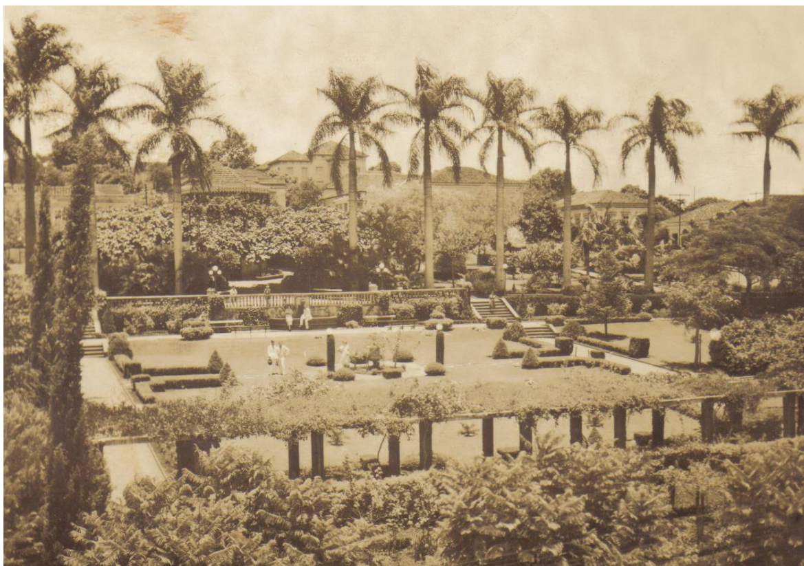
Figura 92: Vista geral do projeto já implantado (s/d)
