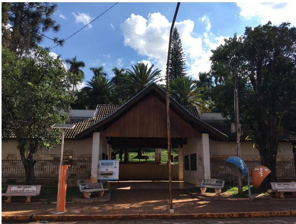
Figura 98: Atual instalação dos banheiros públicos (s/d)
