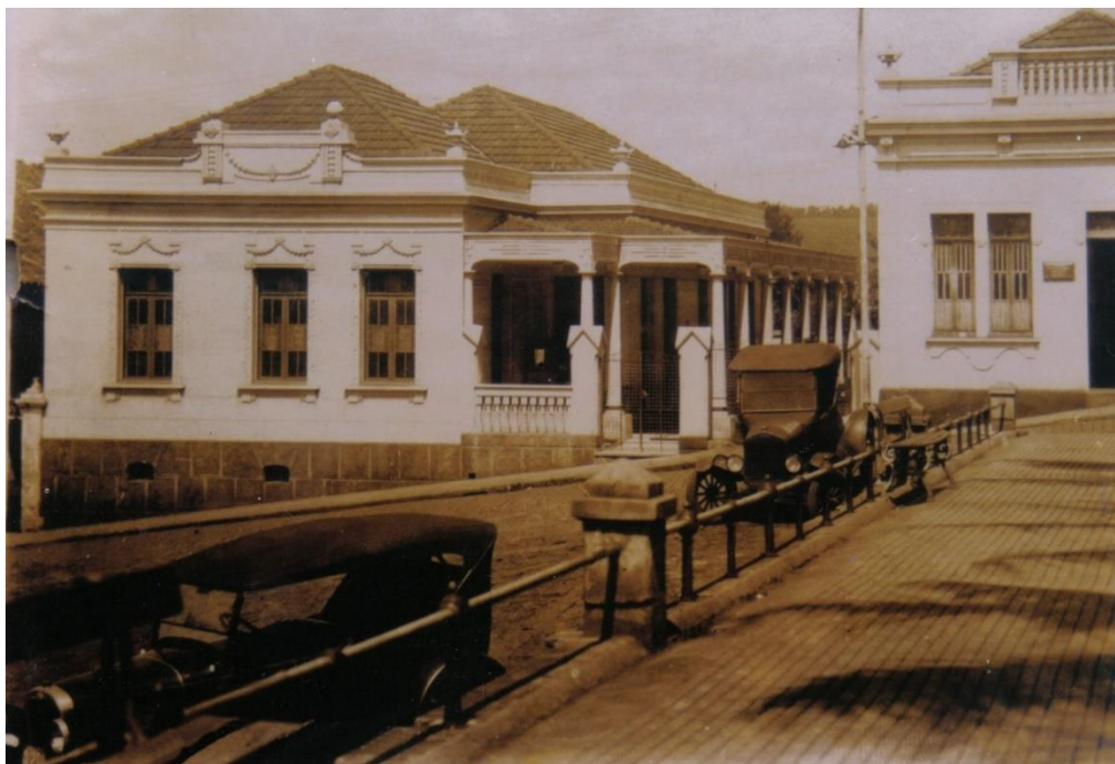
Figura 109: Gradil antes da reforma do “Jardim-Parque em São Manuel”
