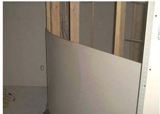
**Figura 13:** Parede curva utilizando-se placas de gesso acartonado.
