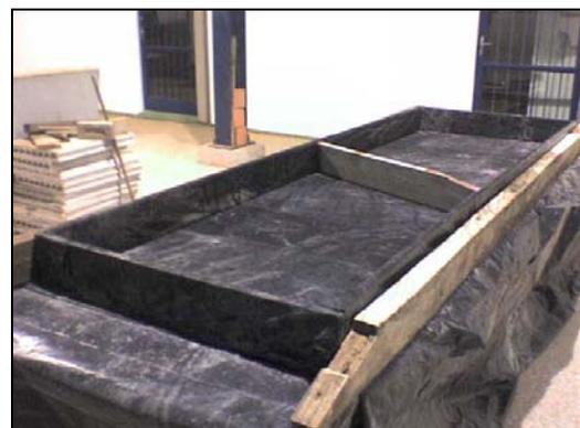
**Figura 40:** Forma forrada com lona plástica.
