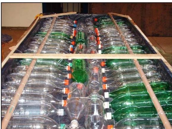
**Figura 41:** Vista das garrafas PET e dos tubos de PVC dispostos dentro da forma.
