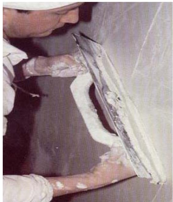
**Figura 11:** Execução manual de revestimento de gesso.
