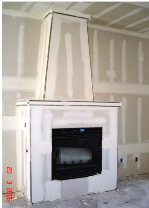
**Figura 14:** Gesso acartonado utilizado em uma residência.
