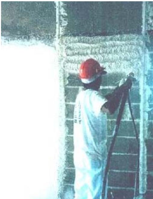
**Figura 10:** Execução de revestimento projetado com argamassa de gesso.
