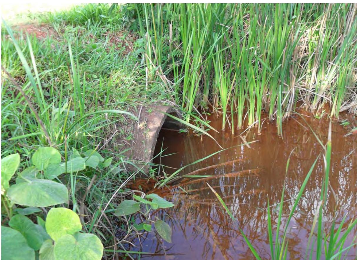
Figura 44 - Tubo de canalização (manilha) implantado no ponto em que a estrada cruza o canal para manter o fluxo de água.
