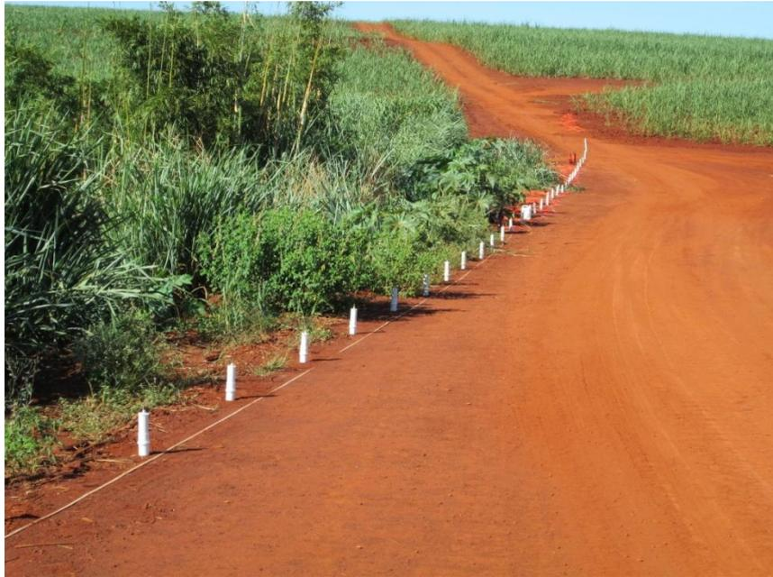
**Foto 6:** Distribuição dos eletrodos na borda da barragem de terra
