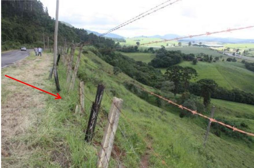
Figura 24 – Feições de rastejo na margem da estrada para São Roque da Fartura, com cercas inclinada.
