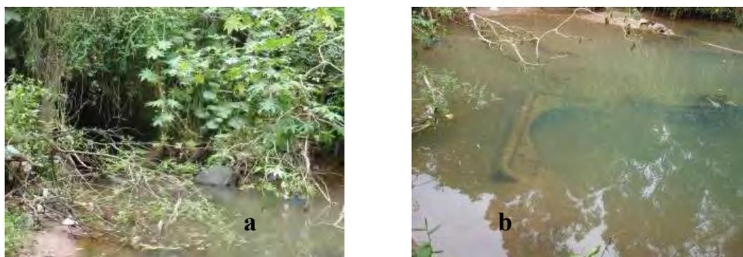
**Figura 14.**Obra de travessia em estado de abandono (a) e manilha “encaixada” no fundo do córrego (b).
