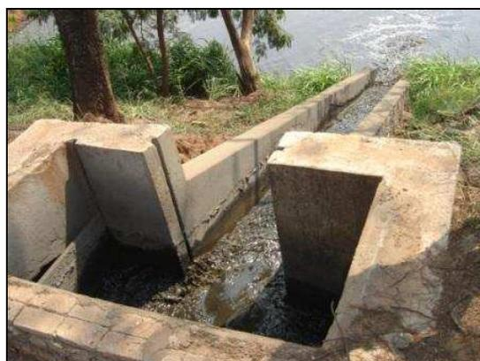
**Figura 21** - Água sendo levada para lagoa de decantação.
