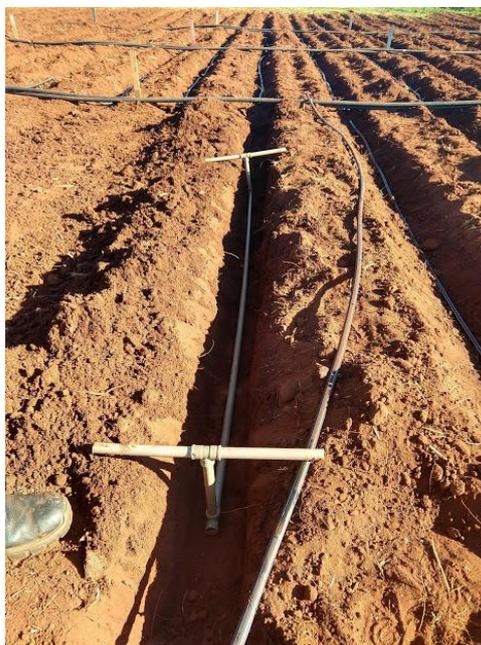
Figura 1. Instalação dos tubos gotejadores.
