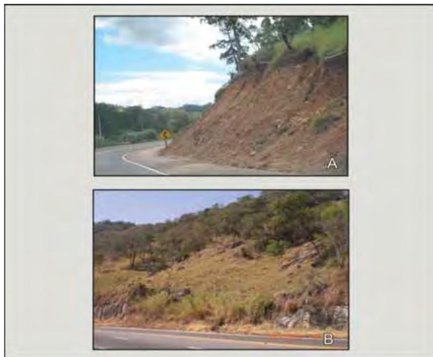
Figura 6.9. A – Escorregamento de terra (planos rasos) na Rodovia SP 360; B – Vegetação seguindo o movimento de encosta (SP 360). Fonte: Martins, S.C. (2011).
