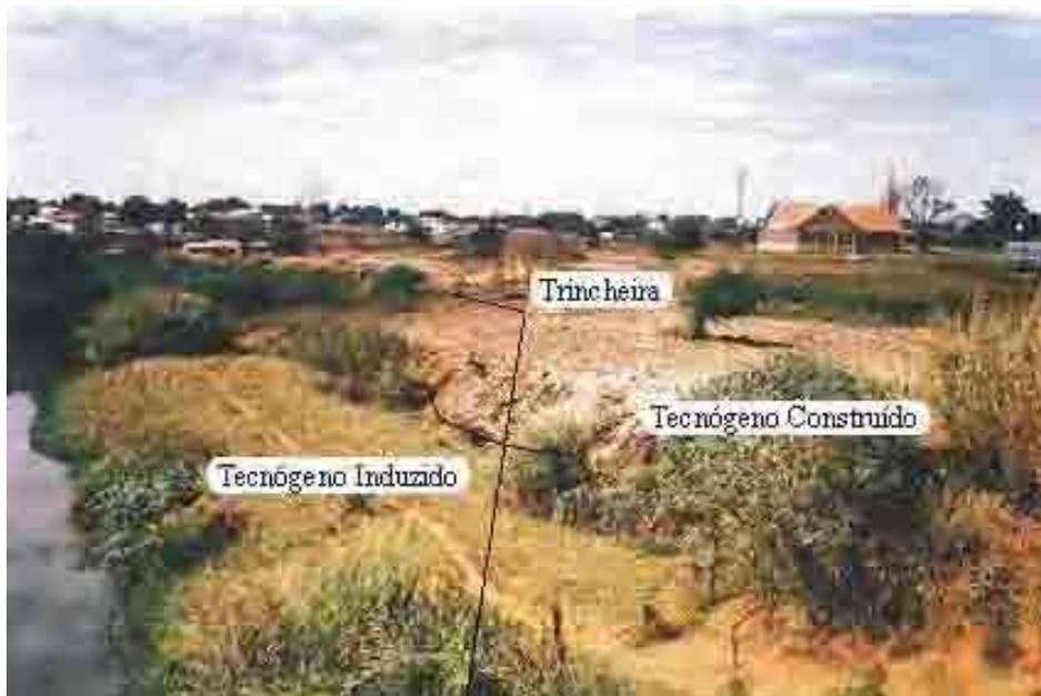
FOTO 7.3 Depósito tecnógeno construído, margem direita do ribeirão Anicuns sobre o qual foi aberta uma trincheira/vala para colocação da tubulação para captação de esgotos. Área de pesquisa de CUNHA (2000).
