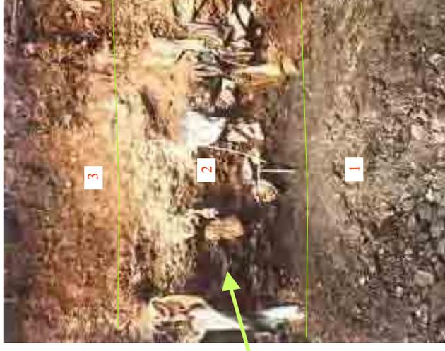
FOTO 7.7 Foto de detalhe: 1- Embasamento, 2- Depósito residual de canal/tecnógeno induzido, 3- Tecnógeno construído
