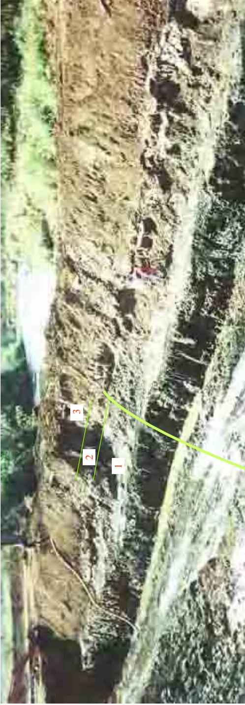
FOTO 7.5 Vista geral das obras de desvio do canal atual do rio Meia Ponte. 1- Embasamento, 2- Depósito residual de canal/tecnógeno induzido, 3- Tecnógeno construído
