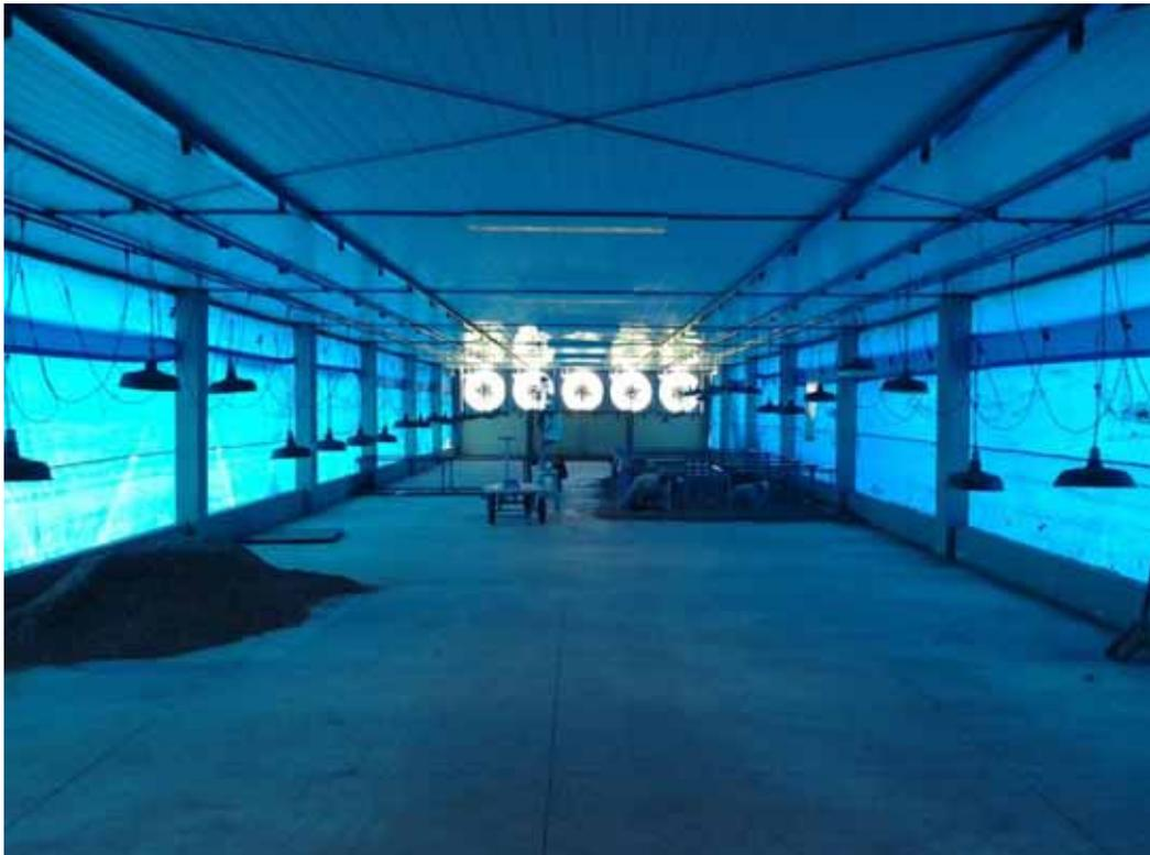
**FIGURA 3 A - Vista interna do galpão, com os exaustores no fundo do galpão para o controle da temperatura.**
