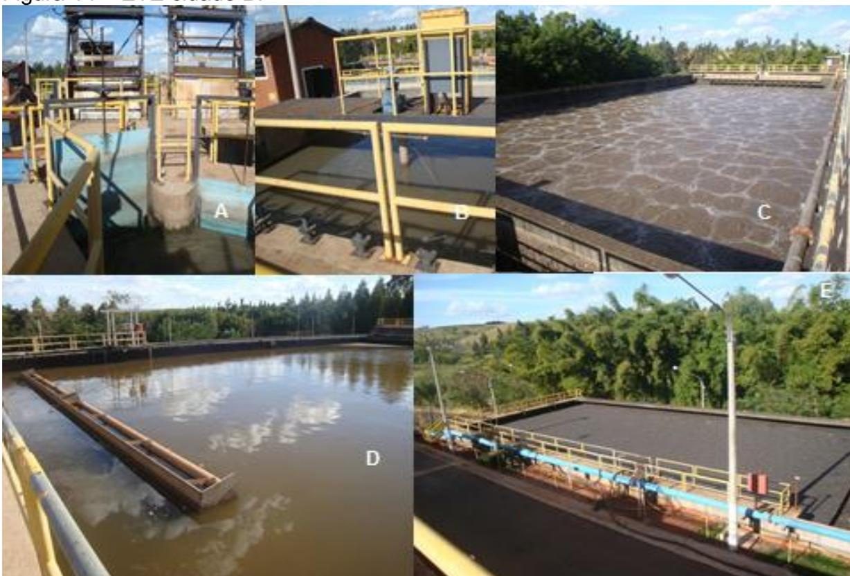
ETE – cidade B. a) entrada do esgoto bruto/ sistema de gradeamento; c) RAFA/ AERADOR; d) esgoto tratado; e) tanque de lodo. Fonte: autor, Agosto de 2012.
