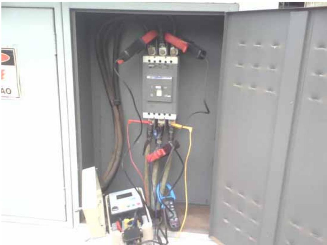
Figura 27. Instalação do Aparelho SAGA no Quadro de Energia
