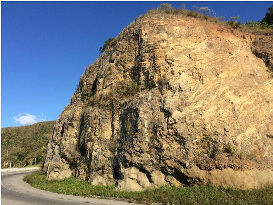
**Figura 32.** Afloramento apresentando tela e gunitagem como medidas de contenção. Entre os pontos 12 e 13.
