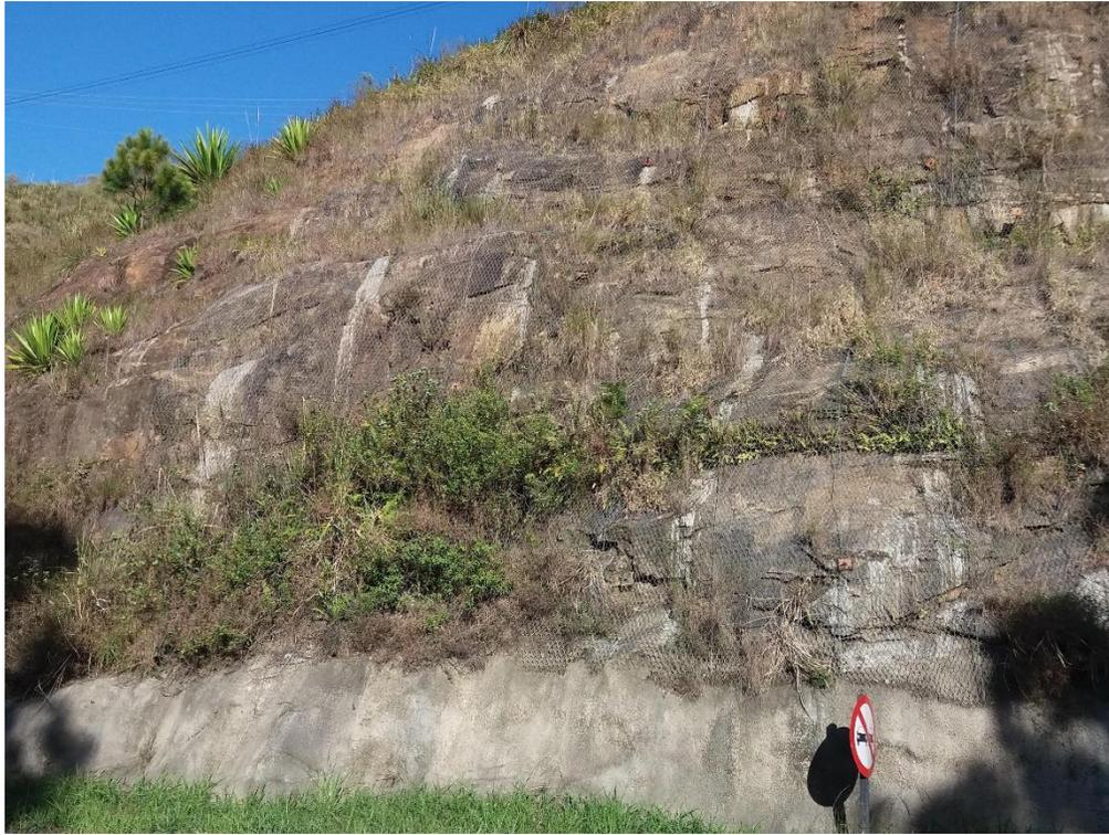
**Figura 33.** Afloramentos de muscovita gnaisse com biotita. Blocos caídos ao lado da rodovia. Entre os pontos 10 e 11.
