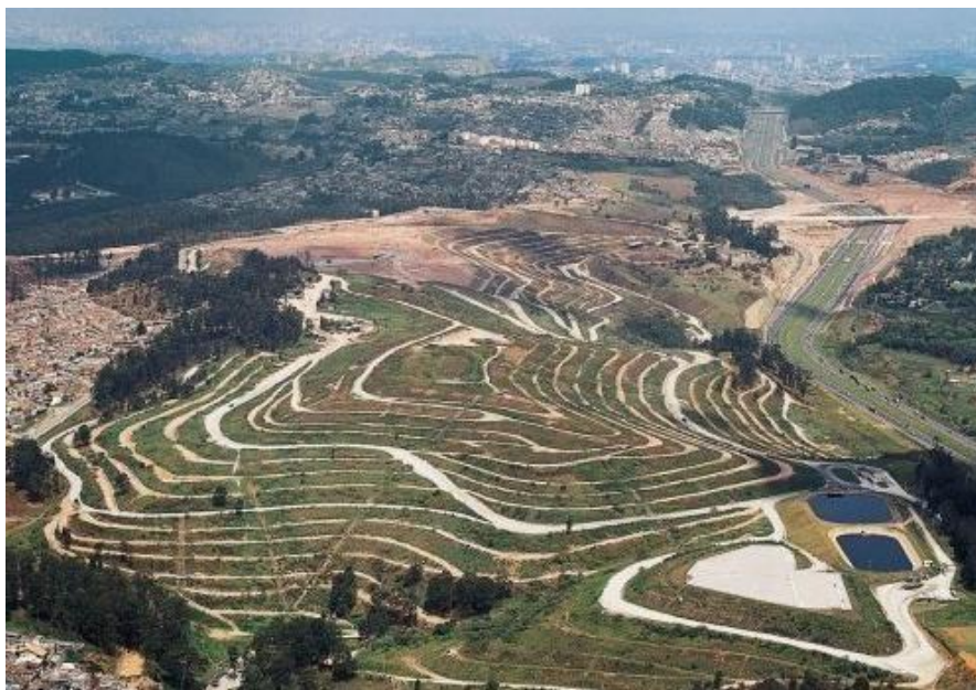
Figura 7 – Vista lateral do Aterro Bandeirantes
