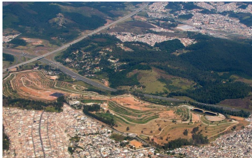
Figura 6 – Vista superior do Aterro Bandeirantes.
